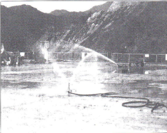
SHIMAJIGAWA DAM Umidificazione del getto
