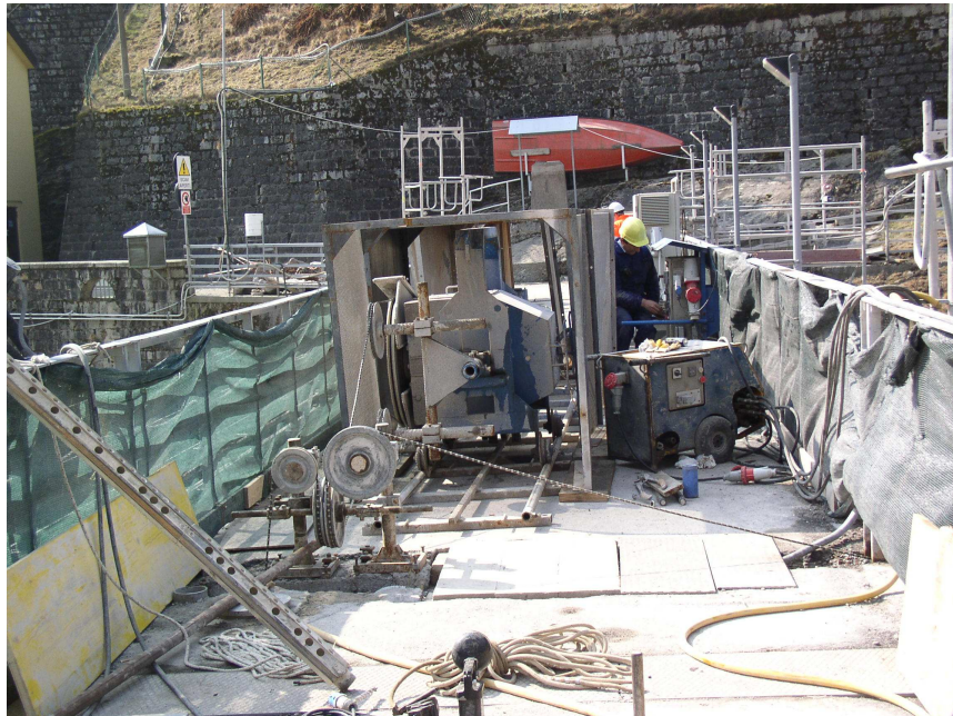
Figura 35. Diga del Poggia – macchina per il taglio con filo diamantato
