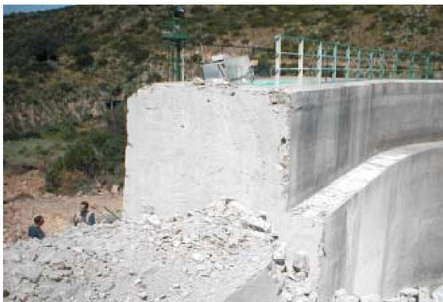
Figura 4. Diga di Corongiu - superficie tagliata con filo diamantato [4]
