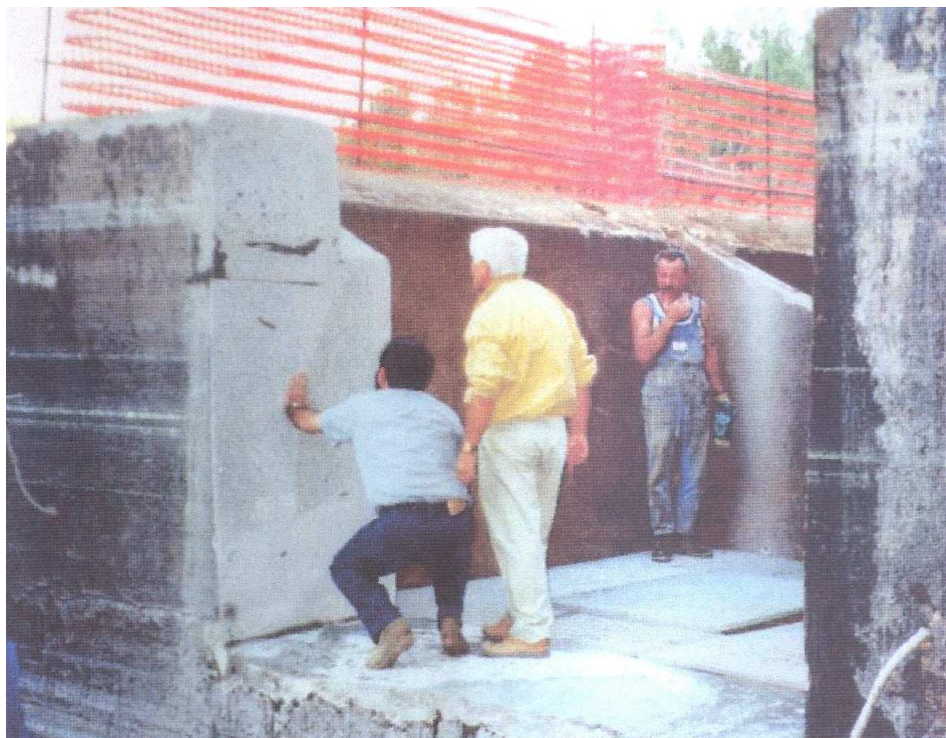
Figura 7. Diga di S. Chiara - superficie tagliata con filo diamantato [3]
