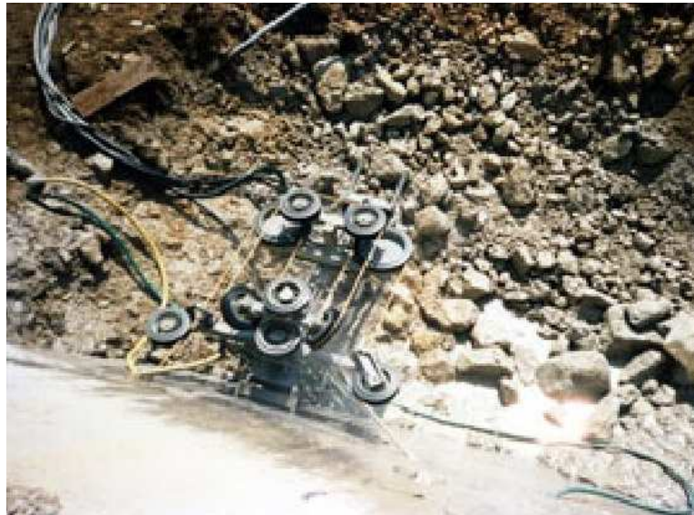
Figura 5. Diga di Combamala - macchina per taglio con filo diamantato [5]
