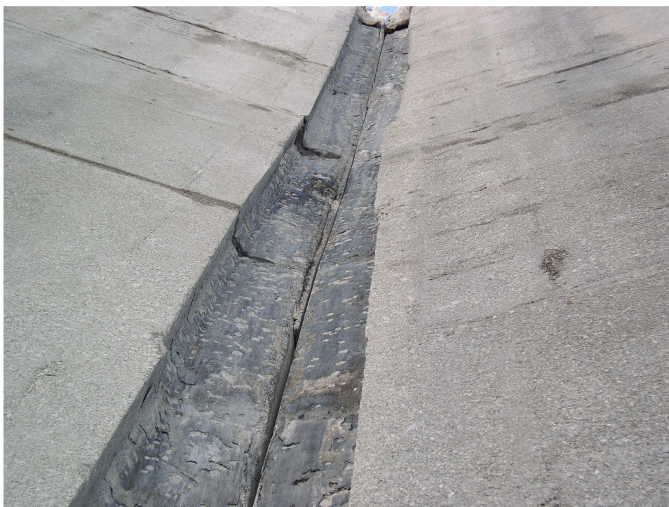
Figura 11. Diga dell'Eugio - vista della "scaglia" nel giunto
