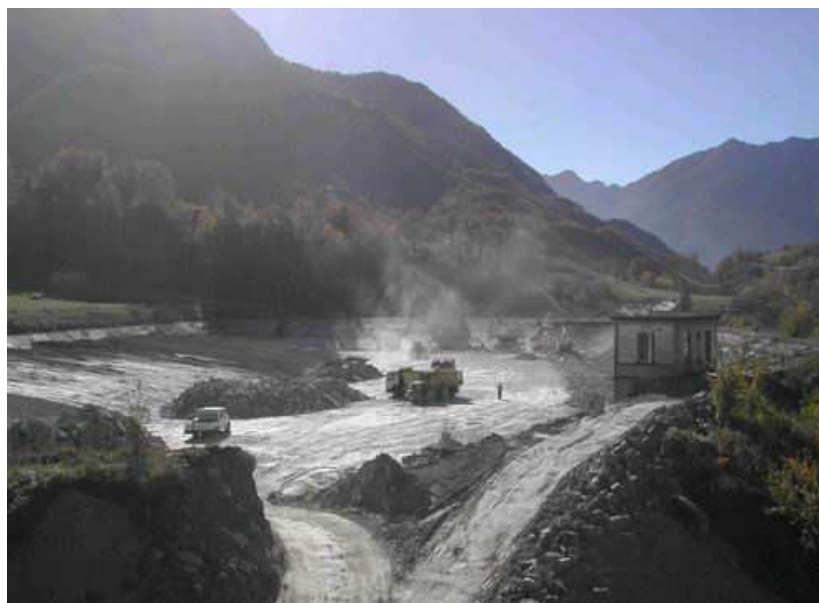
Fig. 5.3 – Vista del bacino nella fase di realizzazione dei lavori
