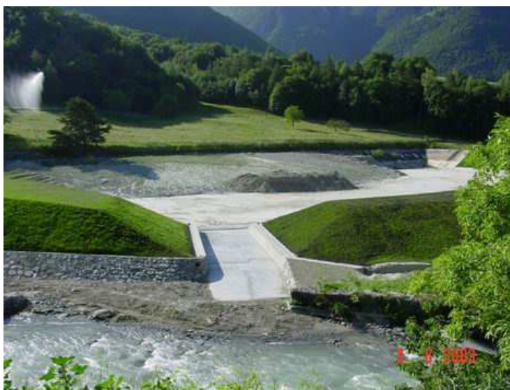
Fig. 5.5 – Vista dell'opera al completamento dei lavori nel Giugno 2003
