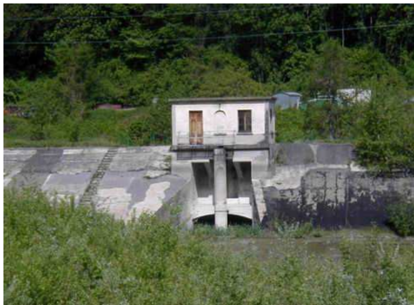
Fig. 5.2 – Vista dell'opera di scarico posta in fregio all'alveo prima della demolizione
