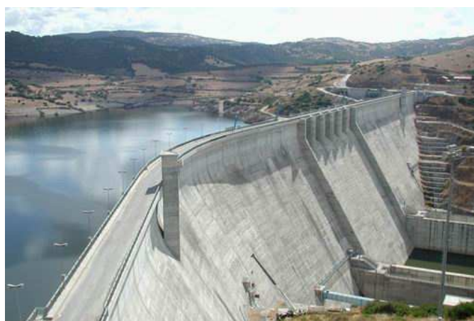
Fig. 5.6 – La nuova diga della Cantoniera sul Tirso vista dalla sponda destra
