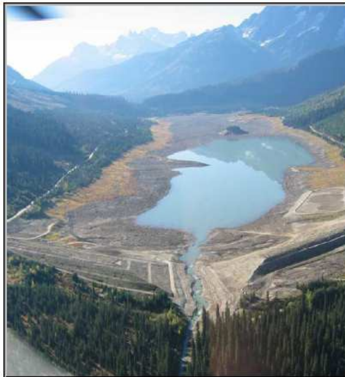
Fig. 5.4 – Vista aerea della diga di Coursier: è visibile la breccia praticata nella parte centrale dell'opera
