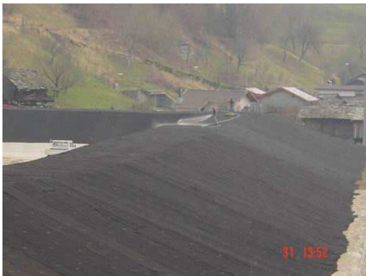
Fig. 5.4 – Completamento della sezione dello sbarramento con posa della rete in materiale plastico e semina di essenze erbacee effettuata nel Marzo 2003
