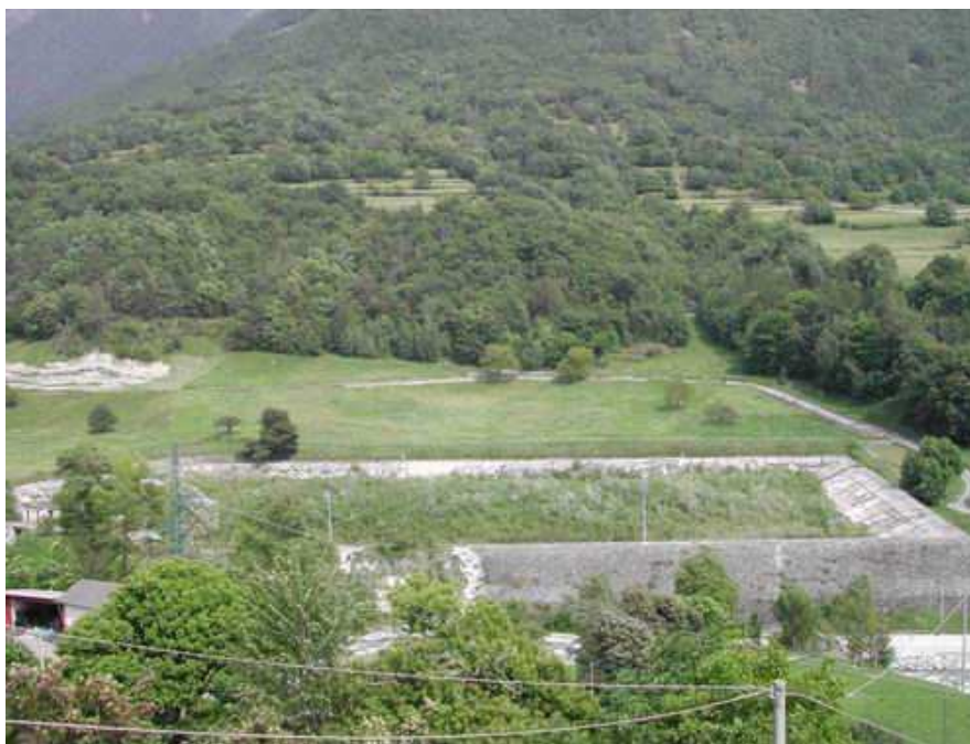
Fig. 5.1 – Vista del bacino di Isollaz prima della dismissione
