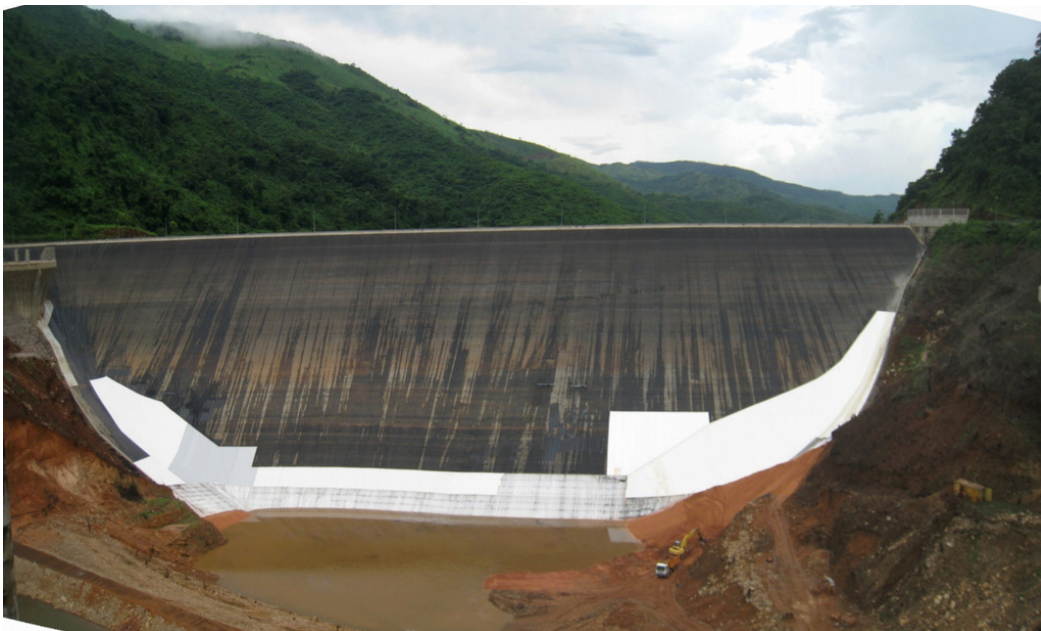
Figura 94 - Vista generale del paramento di monte dopo la seconda fase d'intervento
