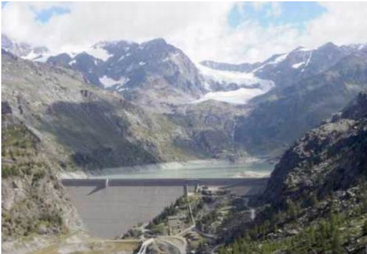
Figura 33 – La diga di Alpe Gera vista da valle
