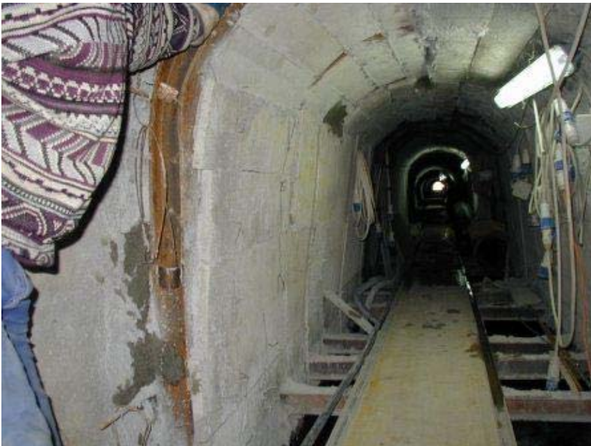
Foto 6 – Rivestimento in gunite armata
