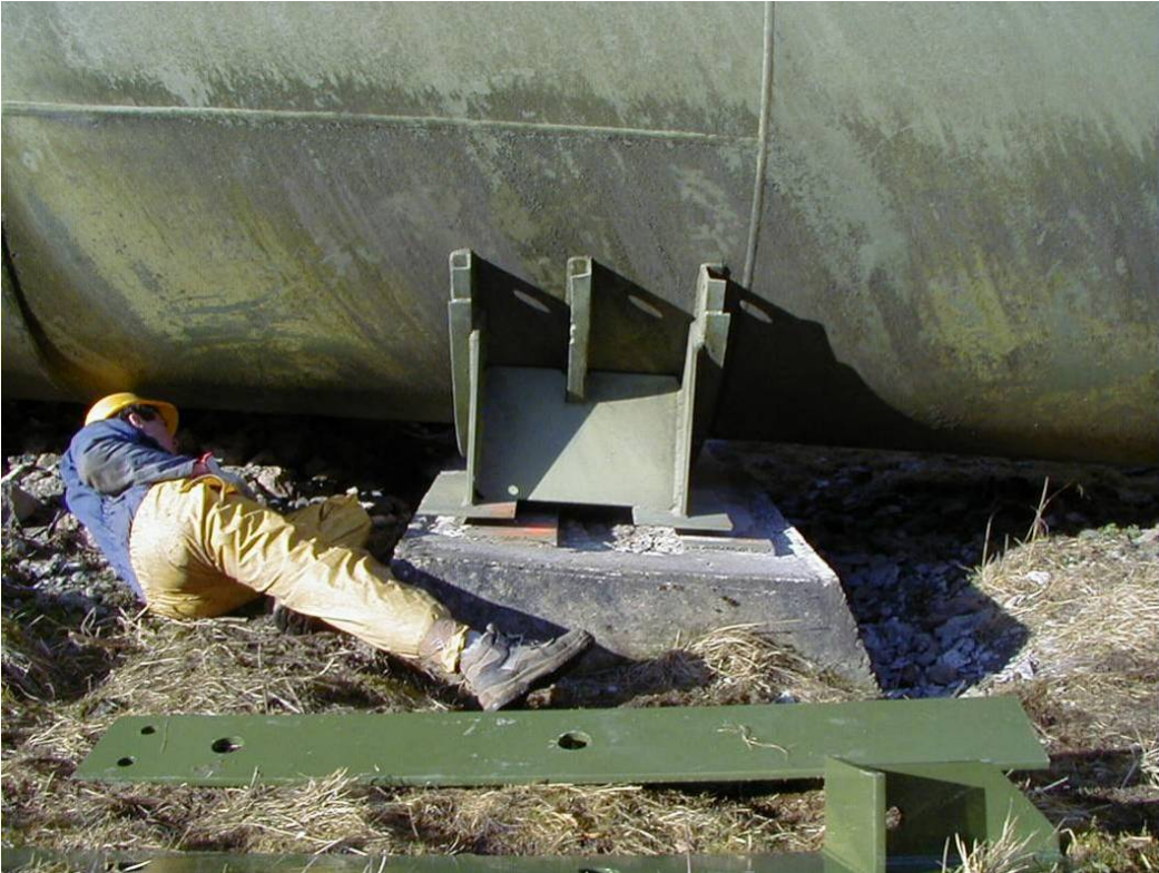
Foto 4 – particolare dello scorrimento verticale di una sella.
