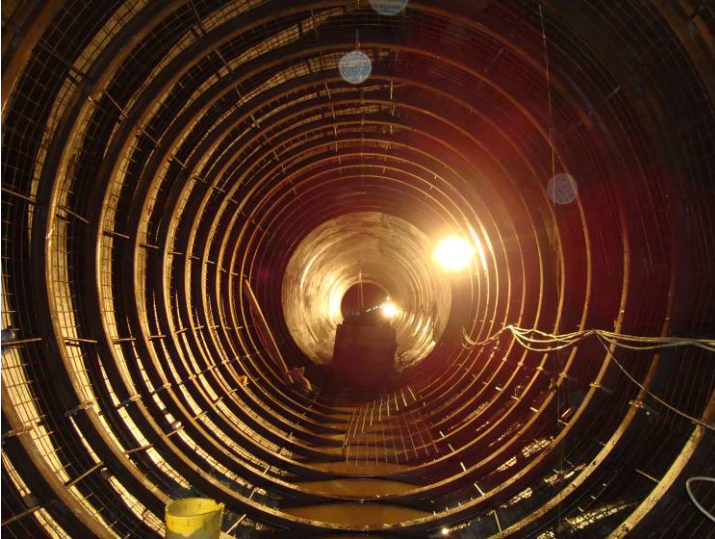
Montaggio Centine Metalliche
