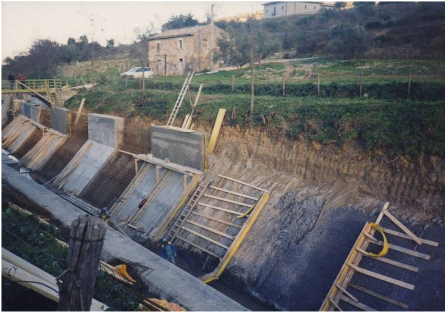
Foto 5 – Ricostruzione per tratti sfalsati, previa interposizione giunti waterstop
