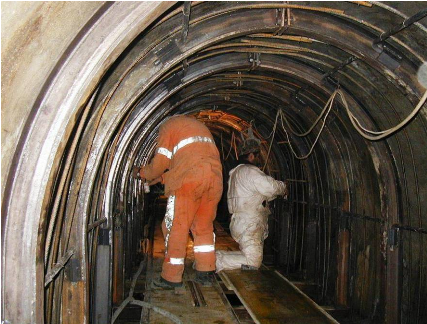
Foto 5 – Posa in opera di centine e reti metalliche
