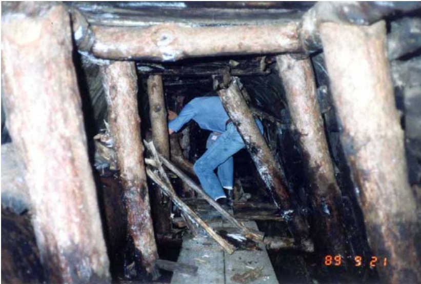
Foto 1 – Puntellatura in legno Intervento eseguito negli anni 80'
