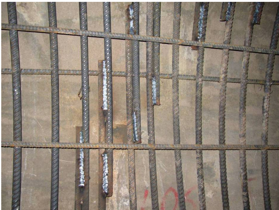
FOTO 5 –Particolare delle saldature di unione delle barre di armatura circolari, sfalsate progressivamente
