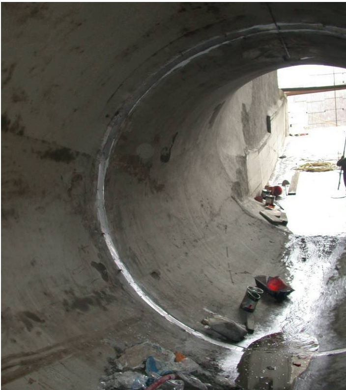
imbocco della galleria di derivazione e giunto di dilatazione
