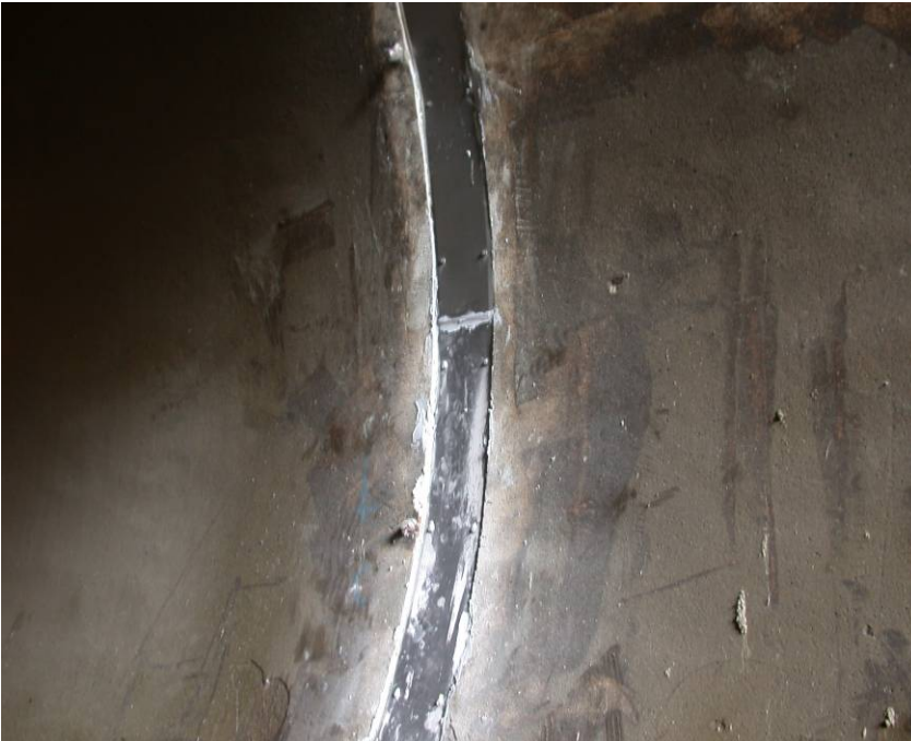
realizzazione del nuovo giunto
