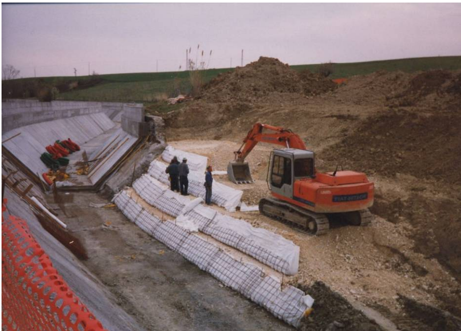
Foto 4 – Rinforzo del terreno con geosintetici
