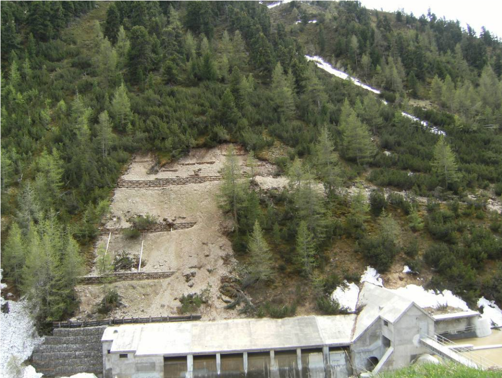
SISTEMAZIONE FINALE DELLA FRANA
