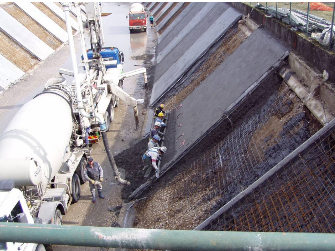
Foto 4 – ricostruzione del rivestimento di sponda – getto delle piastre
