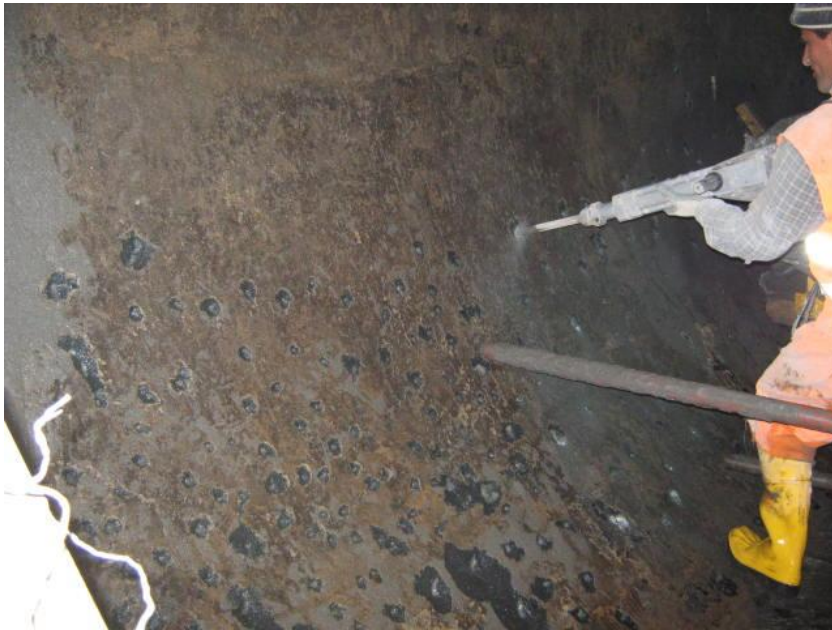
Foto 3 – Intervento di rattivatura delle superfici e perforazioni per ancoraggi
