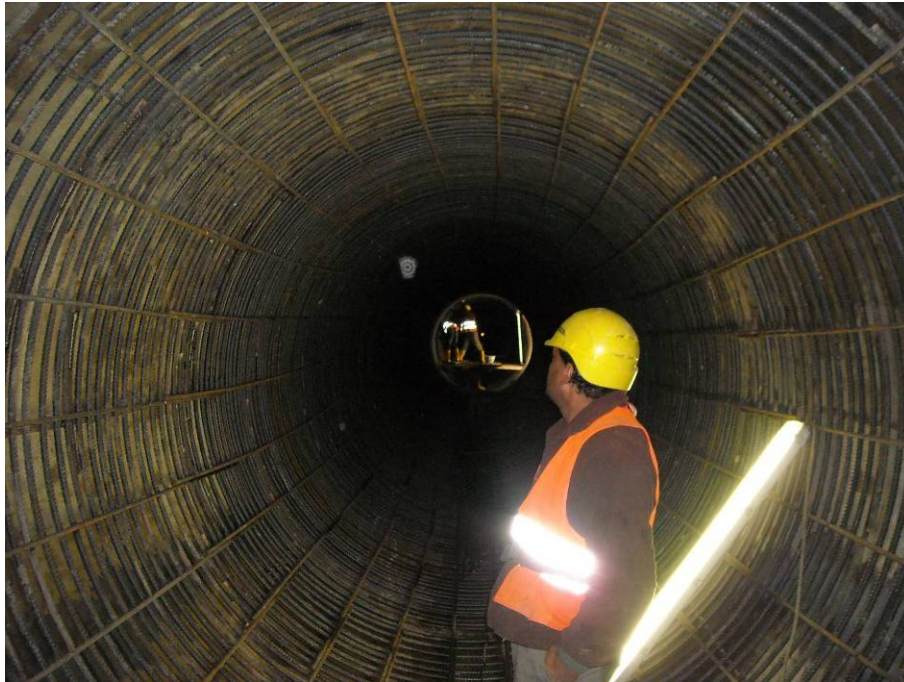
FOTO 6 – Vista generale dell'armatura completa prima dell'applicazione del calcestruzzo proiettato
