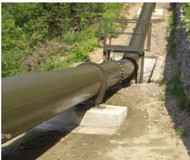
Fig. 13-14-15 – Tipologia degli appoggi delle condotte forzate
