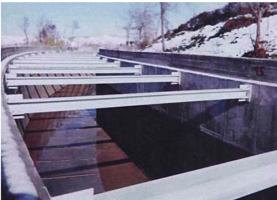
Foto 6 - Irrigidimento con travi metalliche nei tratti a sezione rettangolare
