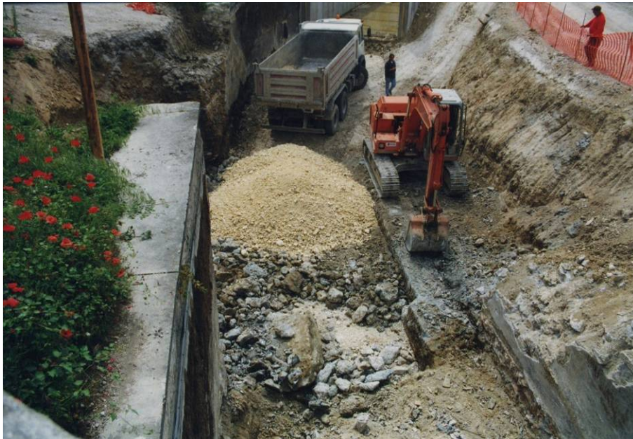
Foto 3 – Riempimento cavità con misto di cava
