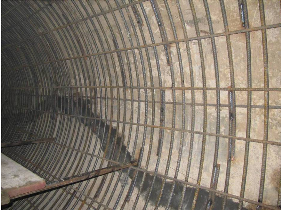
FOTO 4 – Pr. 5520--5572.30 – Sigillatura preliminare delle lesioni ed armatura di rinforzo
