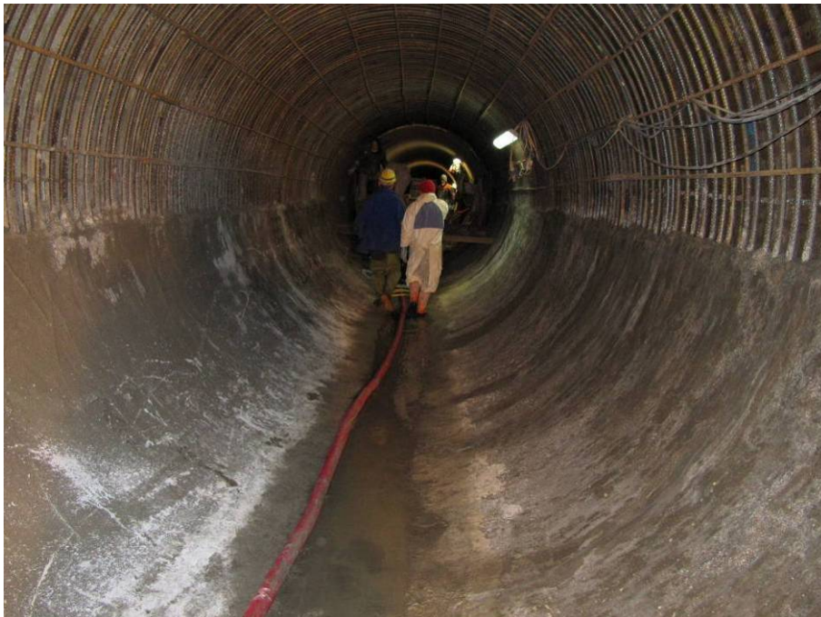
FOTO 7 – Applicazione del calcestruzzo proiettato sulla metà inferiore (prima fase)
