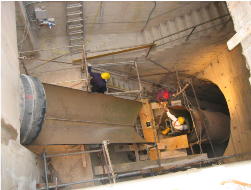
Foto 2 – Apertura vano in testa condotta per l'inserimento del nuovo tubo
