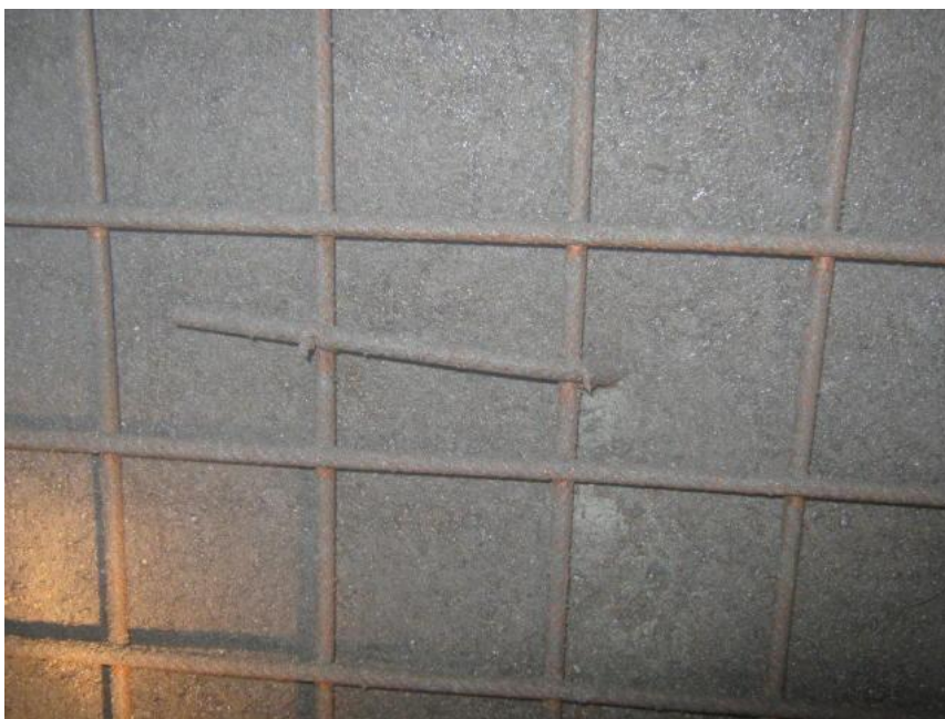
Foto 4 – Posa in opera rete metallica ed ancoraggi
