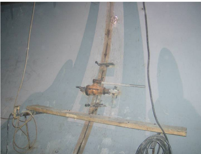
Saldatura delle virole all'interno della galleria
