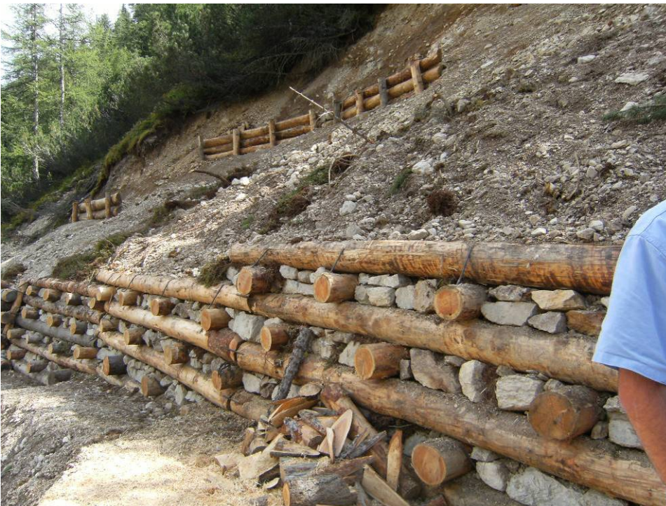
PARTICOLARE DELLE PALIZZATE
