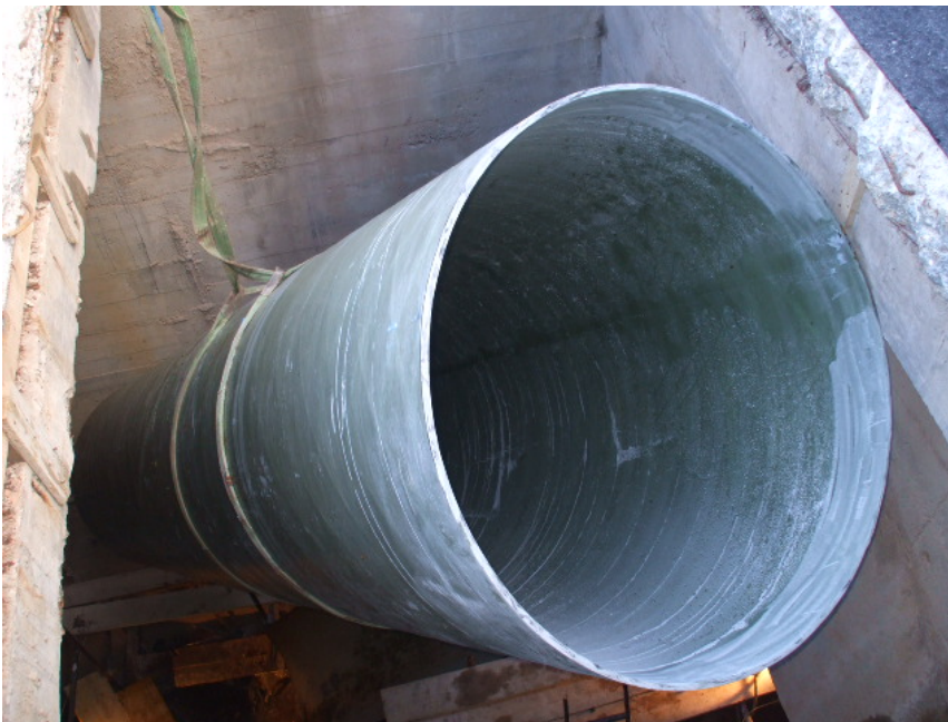
Foto 3 –Calo dall'alto dei nuovi tubi in PRFV
