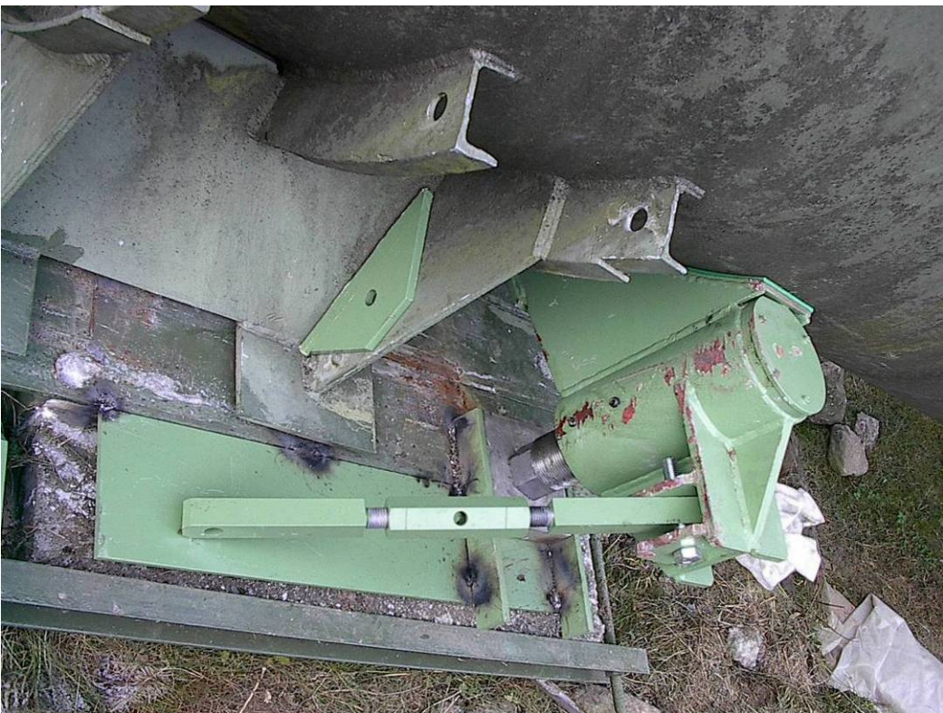
Foto 5 – particolare dei sostegni regolabili con martinetti.
