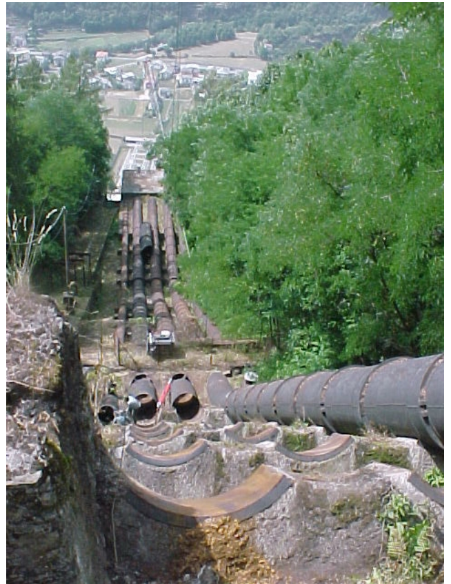
FASE DI RIMOZIONE DELLE
