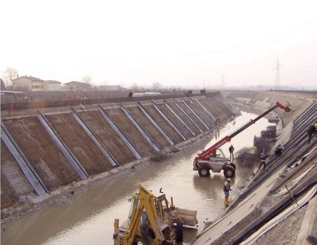
Foto 3 – ricostruzione del rivestimento di sponda – posa dei dreni e delle armature
