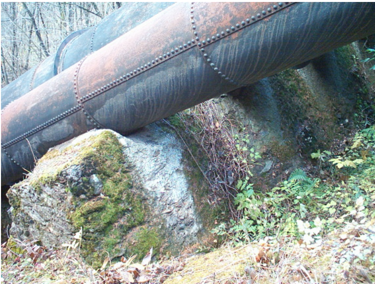
PARTICOLARE APPOGGIO VECCHIE CONDOTTE
