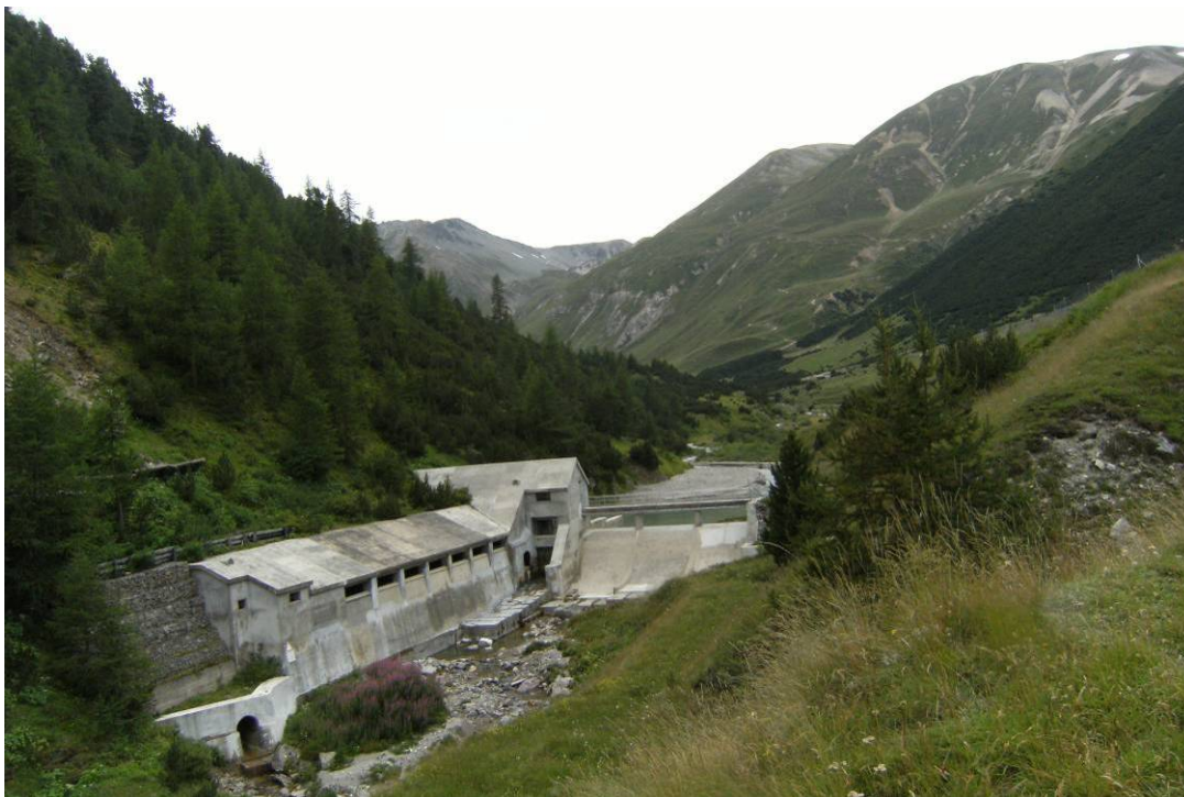
OPERA DI PRESA E DISSABBIATORI – IN SPONDA DESTRA IL VERSANTE IN FRANA
