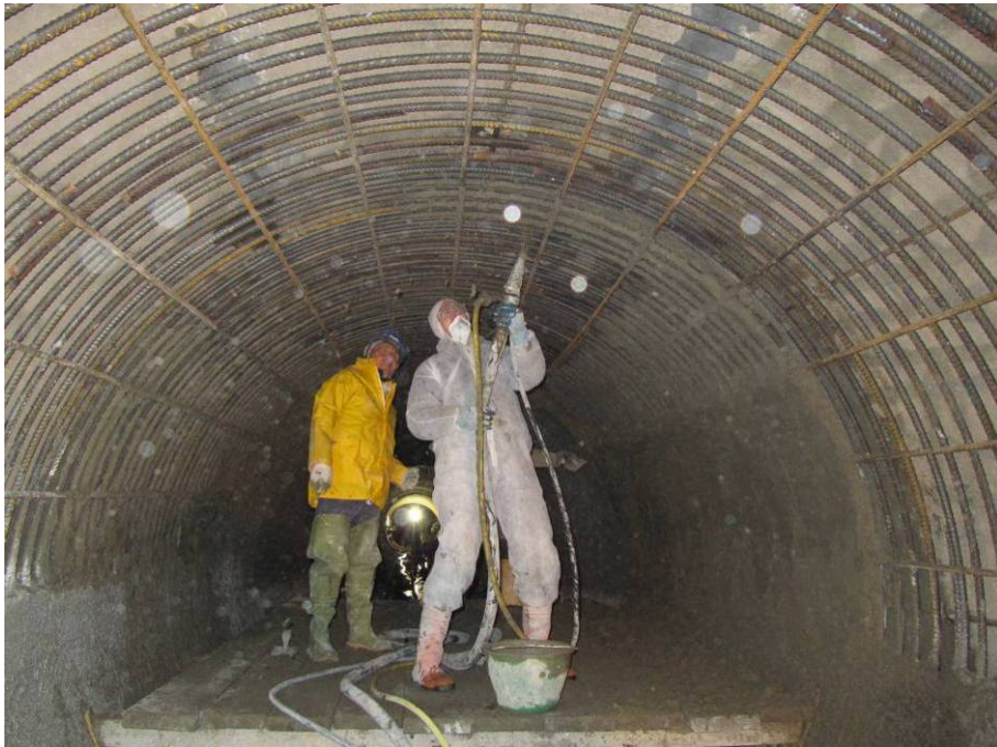
FOTO 8 – Applicazione del calcestruzzo proiettata sulla metà superiore (seconda fase)
