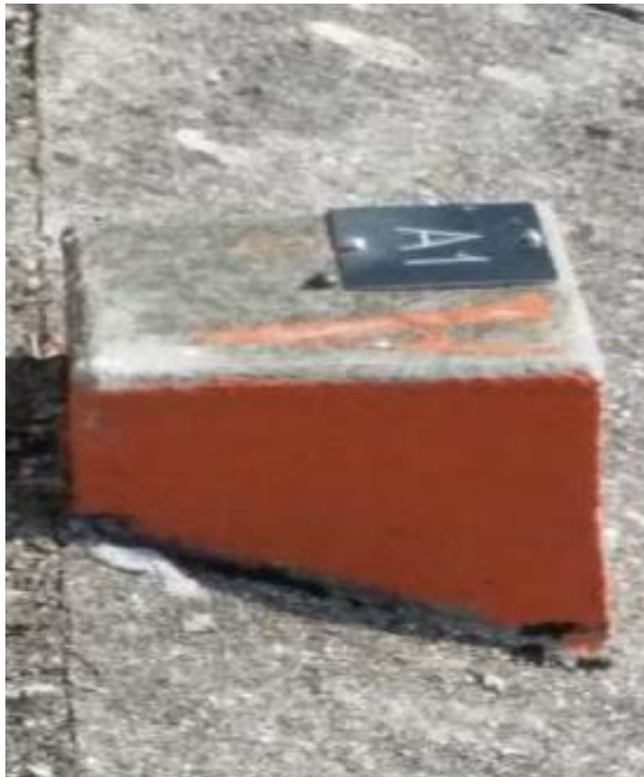
Caposaldo di livellazione sul bordo superiore delle piastre di rivestimento
