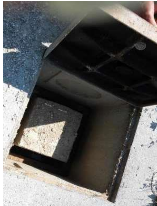
Pozzetto contenente il caposaldo di livellazione posto sul coronamento
