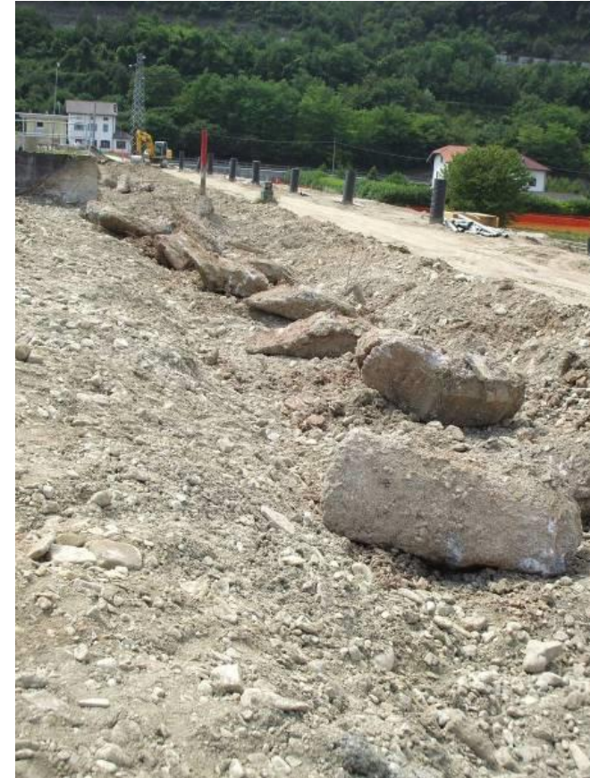
Vista delle vecchie strutture in c.a. rinvenute durante gli scavi (sostegni muretto frangionde)
