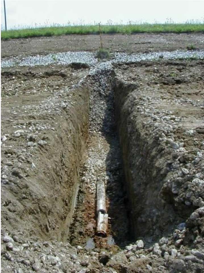
Vecchi drenaggi trasversali (1965)
