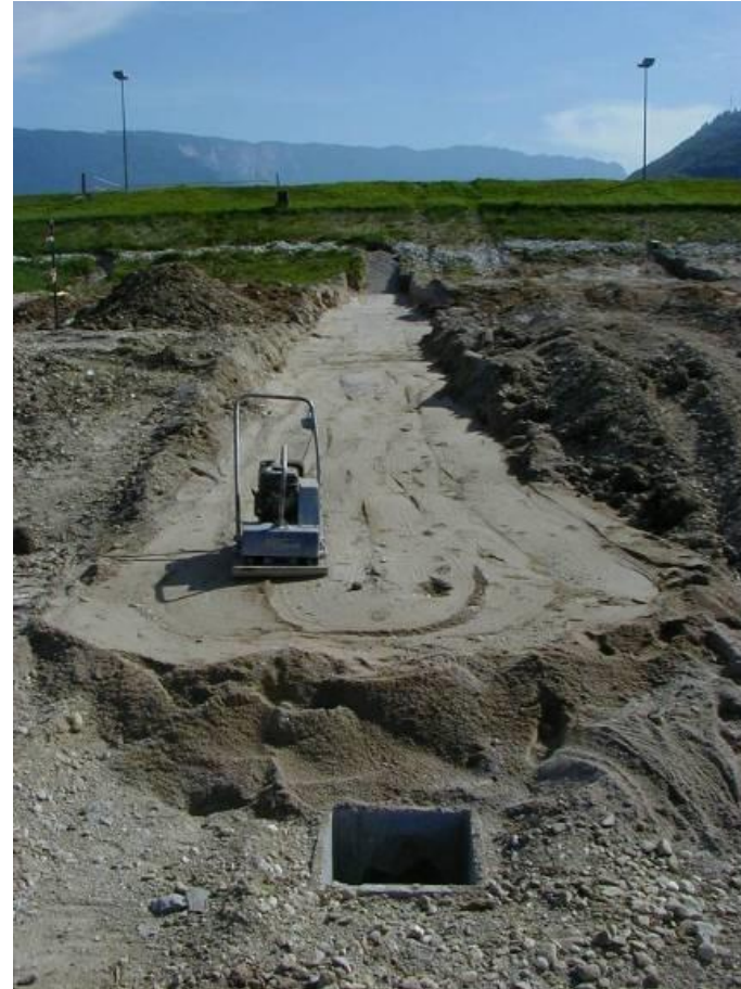
Completamento e compattazione del terreno costituente il filtro
