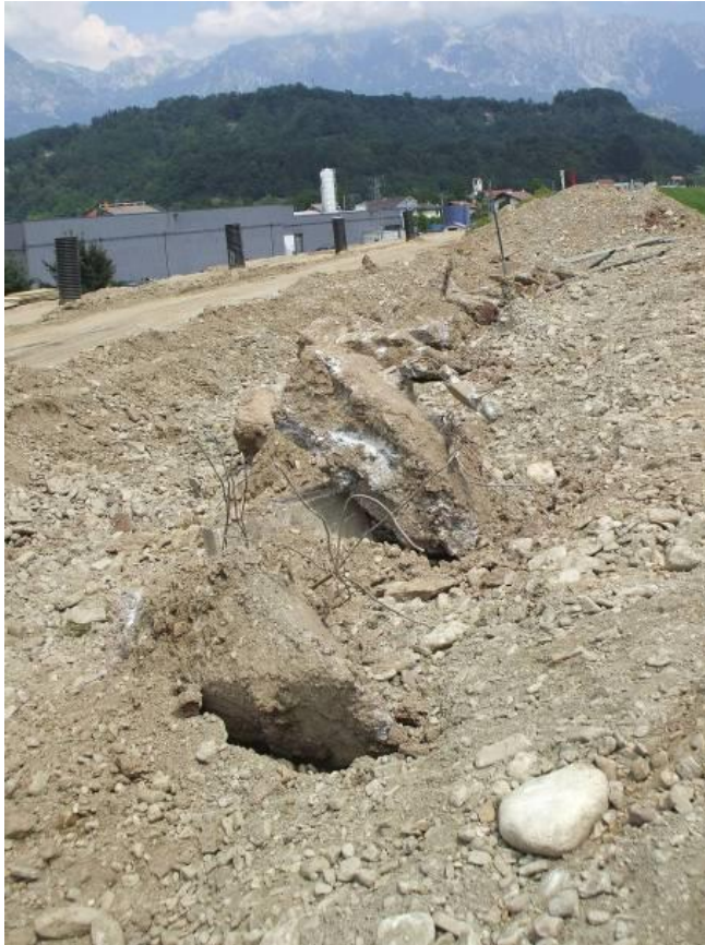
Vista delle vecchie strutture in c.a. rinvenute durante gli scavi (sostegni muretto frangionde)
