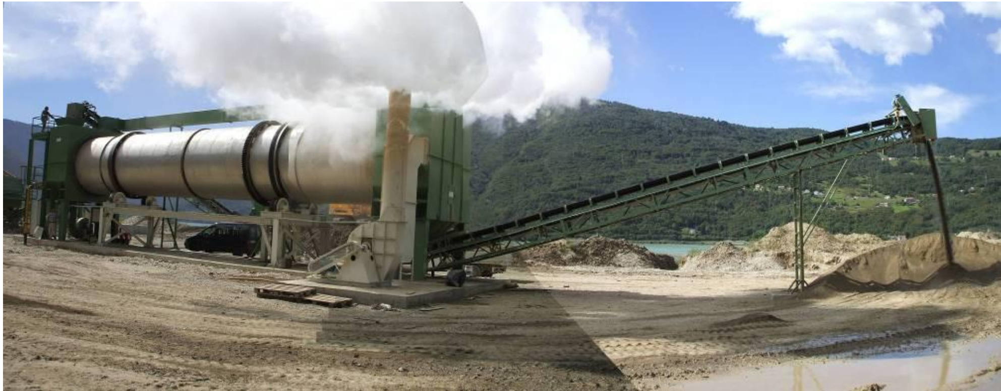
Vista del forno in esercizio con il nastro di scarico del terreno trattato
