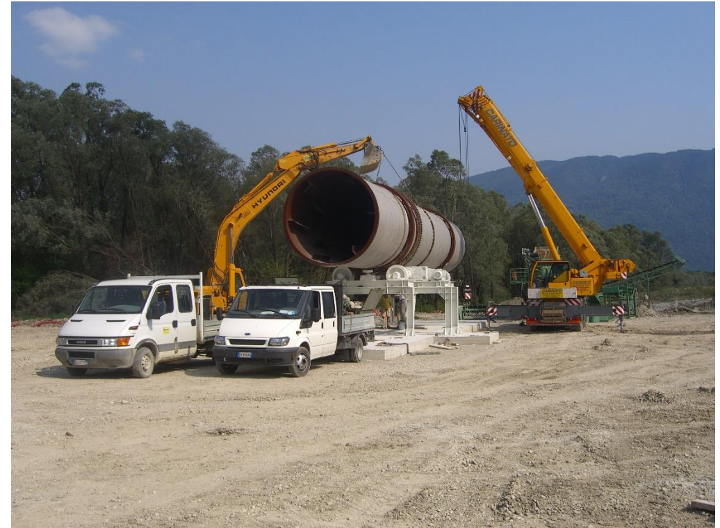
Montaggio del forno
