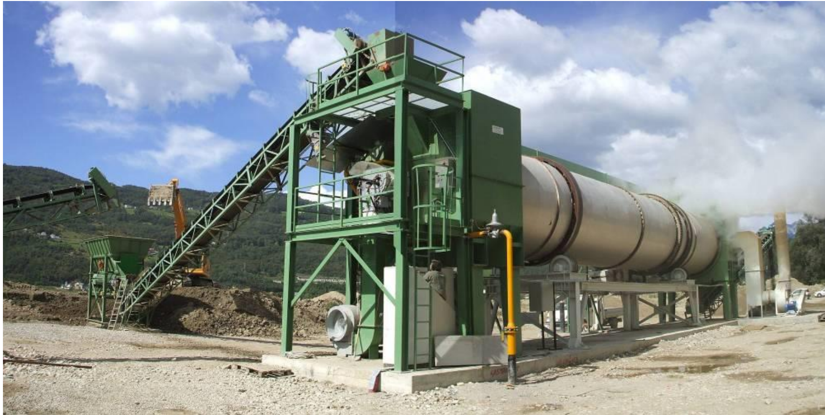
Vista generale del forno in esercizio con la tramoggia ed il nastro di carico
