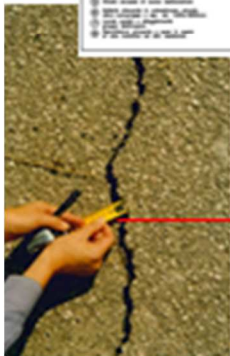
Lesione in asse coronamento
