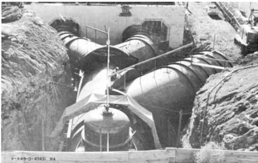
Figura 61 - Derivazione laterale e biforcazione
