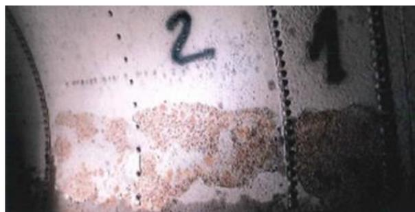
Figura 90 – Scrostatura e ossidazione interna di alcune virole
