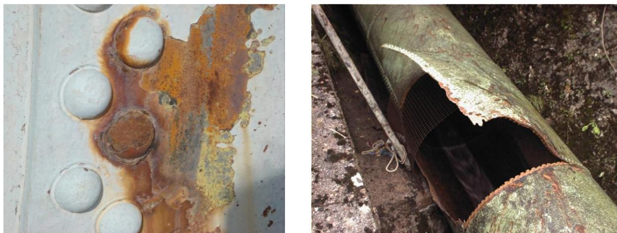
**Figura 2 - Trasudamenti in prossimità di una giunzione chiodata (sinistra) ed esempio di condotta collassata per corrosione in prossimità di una giunzione chiodata (destra)**
