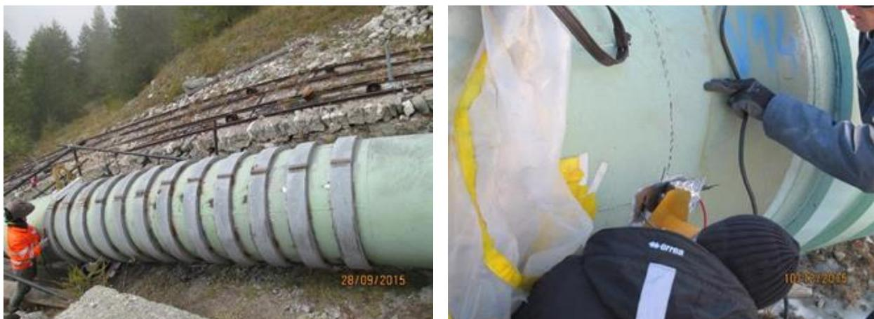
**Figura 156 – Immagini dei lavori di rinforzo localizzati sulla condotta (sinistra) e dell'installazione degli estensimetri a corda vibrante per il monitoraggio deformativo della condotta eseguiti nel 2015 (destra)**
