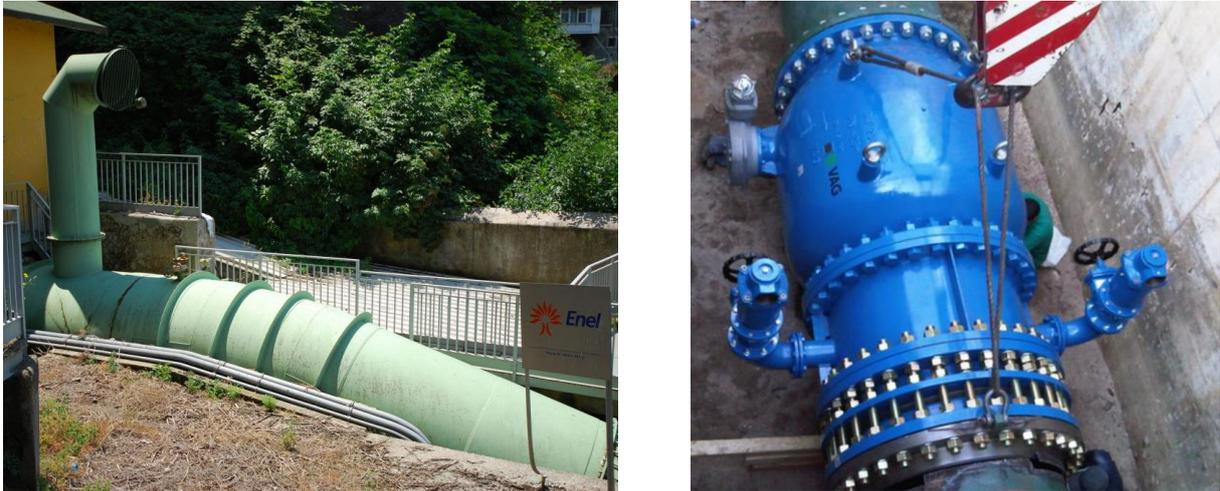
Figura 58 – Tubo aeroforo (sinistra) e valvola rientrata d'aria a galleggiante (VAG DUOJET, destra)
