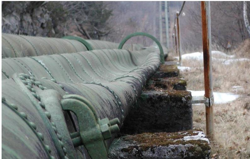
**Figura 118 - Esempio di rottura di una condotta forzata per effetto del mancato funzionamento della valvola di rientro dell'aria [23]**
