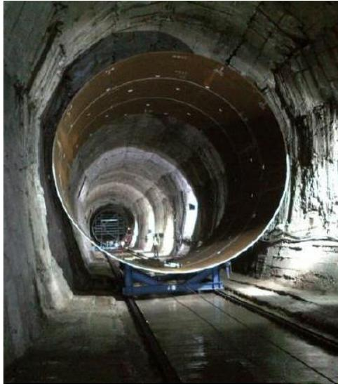
Figura 51 - Montaggio di una condotta in galleria (gentile conc. Camuna)
