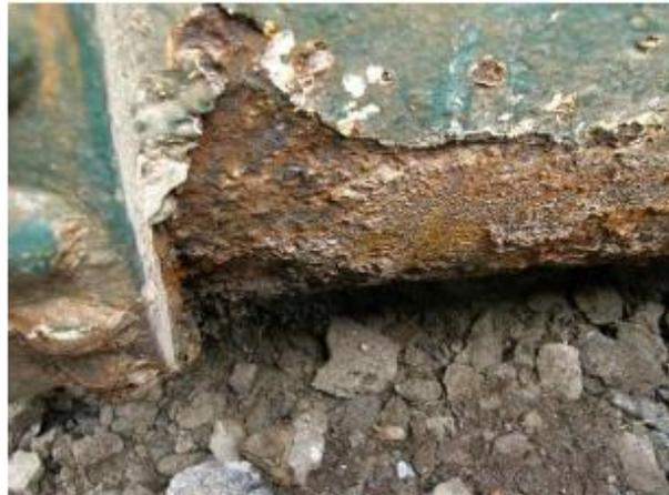
Figura 127 – Effetti della corrosione sulla superficie esterna della condotta
