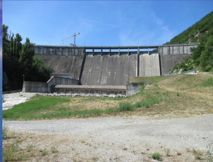
La diga ha recentemente terminato un lungo ciclo di interventi di adeguamento del corpo diga e di adeguamento idraulico degli scarichi con l'ampliamento dello scarico di superficie in corpo diga e la realizzazione di vasca di dissipazione ed opere di restituzione a valle. Si è in attesa dell'emissione del certificato di collaudo ex art. 14 DPR 1363/1959.
