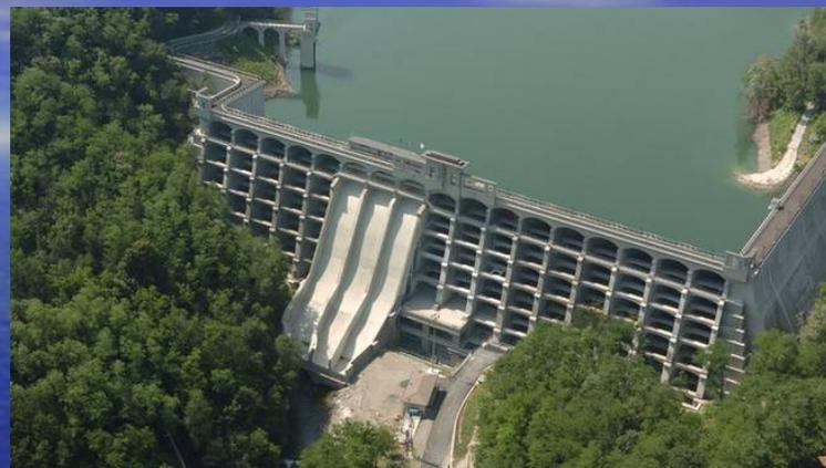
La diga ha recentemente terminato un lungo ciclo di interventi di adeguamento statico del corpo diga e di adeguamento idraulico degli scarichi con la realizzazione di un nuovo scarico di superficie in sponda destra. E' in corso un intervento di completamento dello scarico di superficie in corpo diga con la realizzazione di nuove opere di restituzione in alveo, costituite da un tratto di canale e da una vasca di calma e restituzione in alveo al termine dello scivolo.
