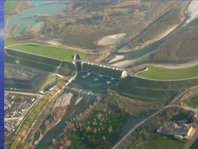
E' composta da un bacino di ritenuta di circa 136 ettari, delimitato da arginature, e da uno sbarramento, di circa 24 metri di altezza ed uno sviluppo di 110 metri lineari, oltre a due sfioratori a "becco d'anatra" laterali. E' dotata di 3 luci di scarico di fondo, regolate con paratoie.
