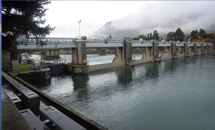
La traversa di Olginate, regolatrice del lago di Como, è già stata soggetta ad estensivi interventi di manutenzione delle opere elettromeccaniche (con sostituzione delle paratoie) e delle opere civili, con interventi in fondazione diretti ad eliminare fenomeni di sottofiltrazione.
