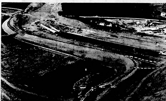
Fig. 2 - Vista del rilevato dell'avandiga dalla sponda destra.
