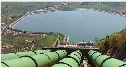
L'impianto ha una potenza massima in generazione di circa 1.000 MW, in grado di alimentare l'equivalente di 350.000 utenze.
