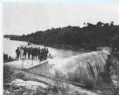
La diga di Pagnona sbarra il torrente Varrone immissario del lago di Como all'altezza dell'abitato di Dervio (LC) . E' una diga a gravità in muratura di pietrame e malta, ultimata nel 1923.
