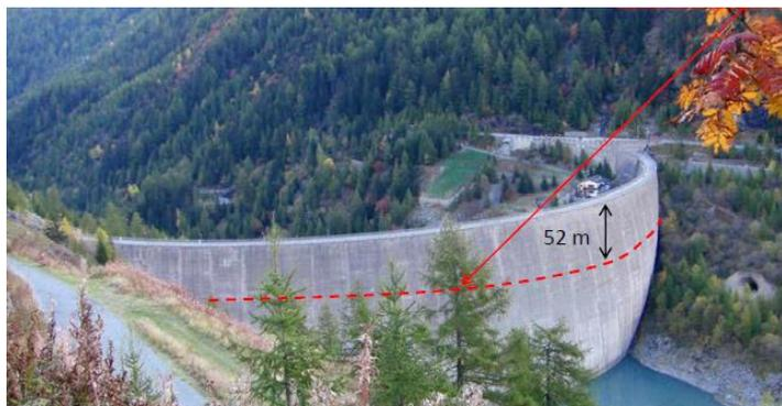
Fig.A4 - Situazione originaria dello sbarramento con indicazione della riduzione di altezza (linea rossa tratteggiata). Altezza pari a 132 m e Volume utile pari a 70.000.000 mc. (ante 2011)
