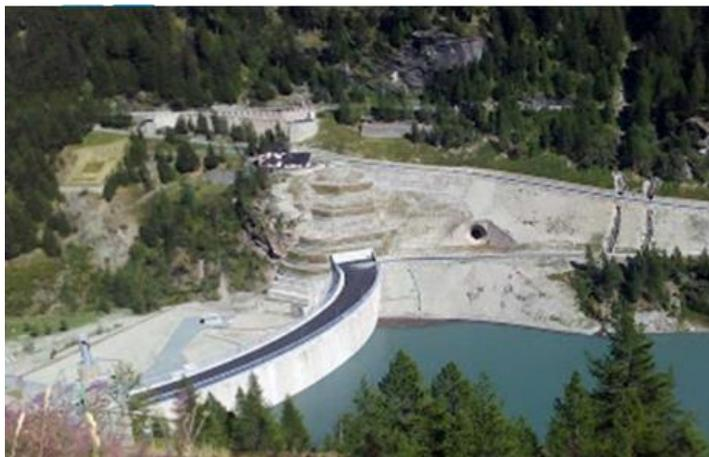
Fig.A6 - Situazione attuale dello sbarramento con altezza pari a 80 metri e Volume utile pari a 3.6000.000 mc. (post 2015)
