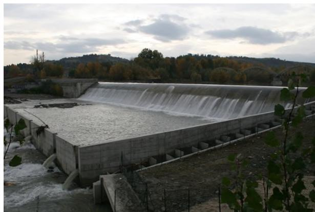
Fig. II-10 - Condizioni dello scarico all'entrata in funzione dell'impianto
